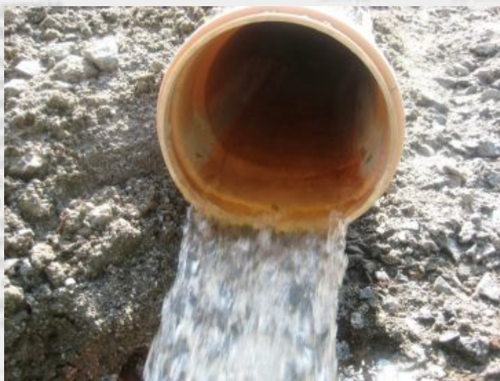
Выпуск очищенных сточных вод в р. Вуокса – водоем рыбохозяйственного значения
