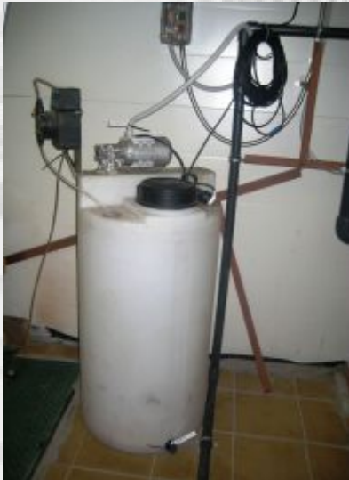
Реагентное хозяйство овицидного препарата для совместной дегельминтизации сточных вод и осадков
