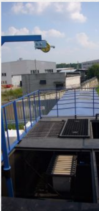
Монтаж мембранных блоков
