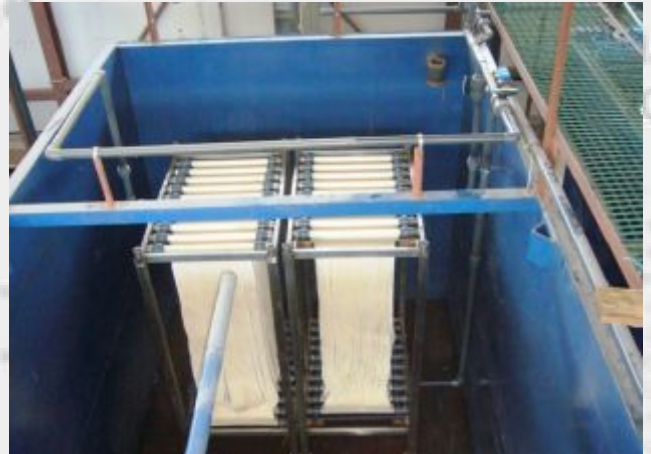
Монтаж мембранных блоков
